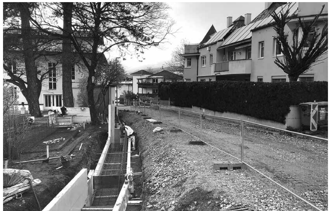
Erneuerung bzw. Erweiterung der Infrastruktur erfordert auch einige Bauarbeiten im Straßenbereich.
