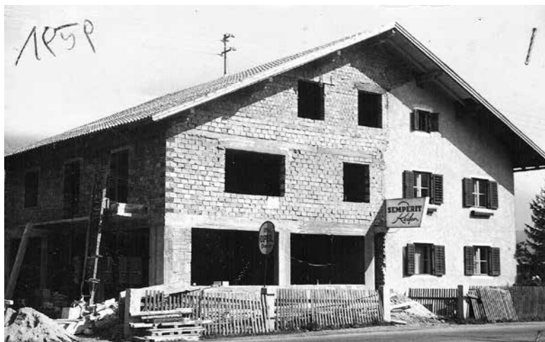
KFZ Werkstatt in der Familienhausgarage an der Innsbruckerstraße.
