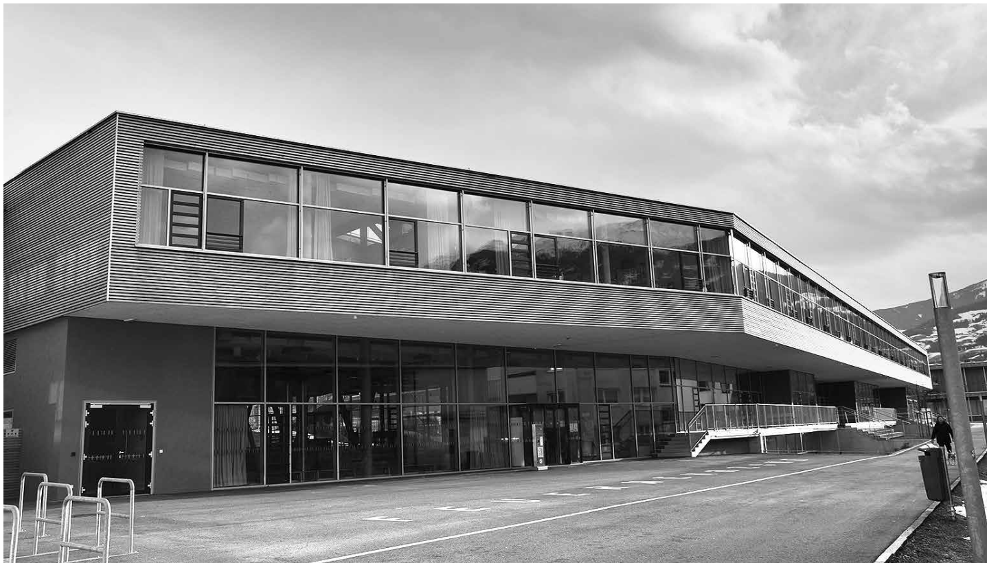
Auf dem Dach des Schulzentrums Hall soll eine Photovoltaikanlage errichtet werden.
