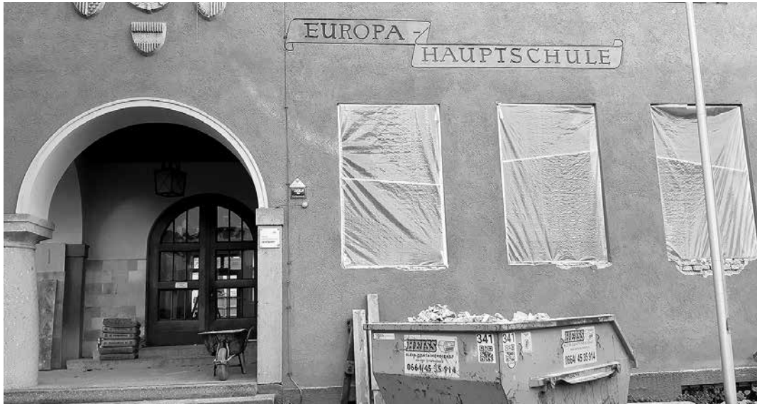
Die Umbau- und Sanierungsarbeiten im Haus Bachlechnerstraße 2 sind voll im Gange.
