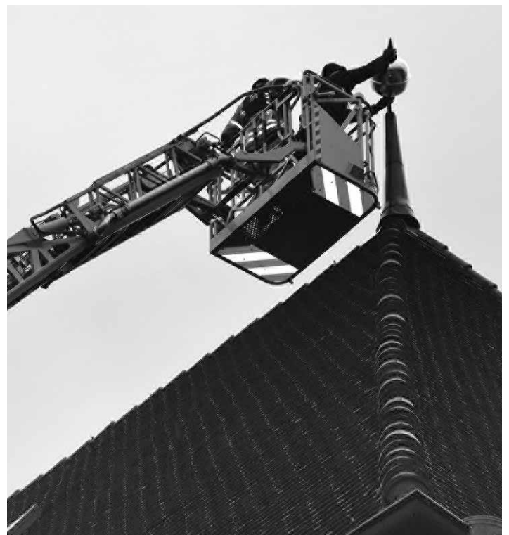
In luftiger Höhe, im Korb der Feuerwehr-Drehleiter stehend, wurden die beiden neu vergoldeten Kugeln, auch Knöpfe genannt, montiert.
