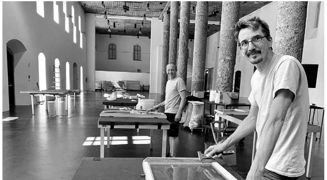
Wolfgang Wallner und Christian Draschl bei der Sanierung der sechzig (!) Fenster im Haller Salzlager. Fotos (2): Stadtmarketing Hall
