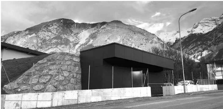
Trinkwasser-Hochbehälter „Hallthalerhof“. Foto: Hall AG
