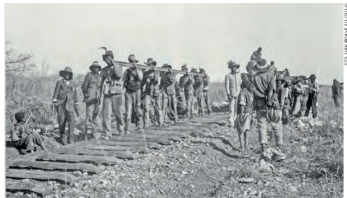
Bau an der Otavi-Eisenbahn bei Okaputa, 1905.
