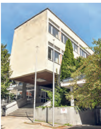
Das in den 1960er Jahren errichtete Schulgebäude in Schönegg bedarf einer Generalsanierung.
