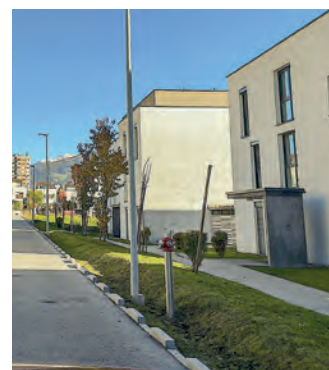
Eine funktionierende Oberflächenentwässerung im Idealzustand.
