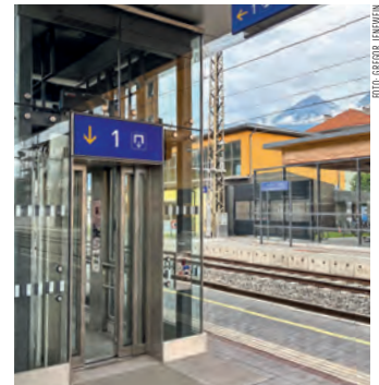
Der Lift ist bereits wieder in Betrieb.
