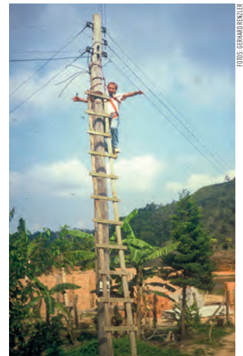
Die Versorgung mit Elektrizität und die Installierung einer Telefonleitung.
