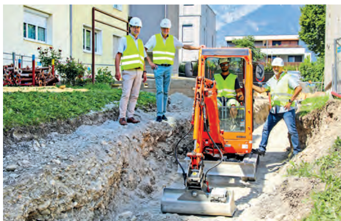
Im Rahmen einer Baustellenbesichtigung überzeugten sich Dipl.-Ing. Mag. Artur Egger, technischer Vorstand der Hall AG und Ing. Franz Mariacher, Geschäftsführer der TIGEWOSI, persönlich vom Baufortschritt.
