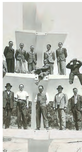
Stolze Bauarbeiter nach dem Aufstellen des Sprungturmes.
