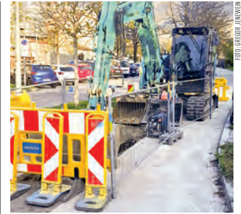
Baustellenstart am Stadtgraben.
