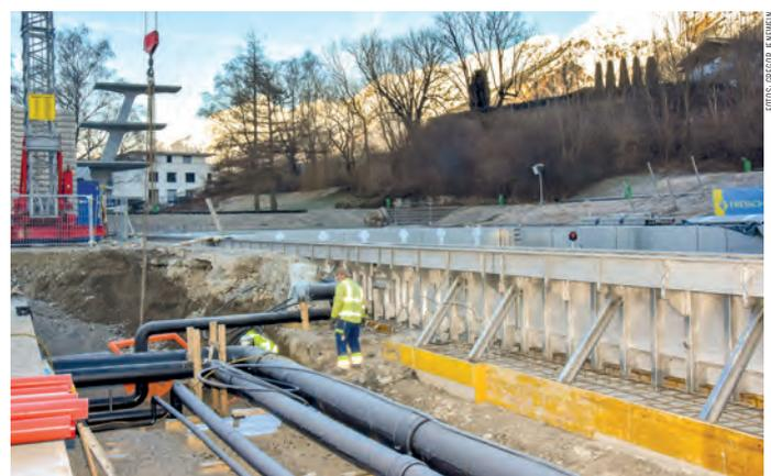
Neue Rohrleitungen verbinden den Technikraum mit den Schwimmbecken.
