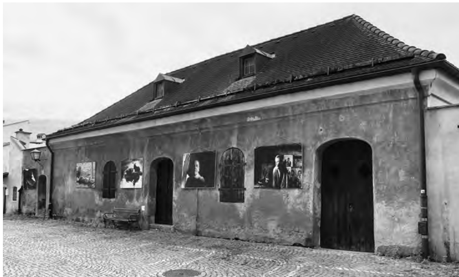
Die Schneiderkapelle: vom Lagerraum zum Kulturzentrum.
