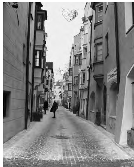
Die neue Pflasterung weist eine deutlich glattere Oberfläche auf.
