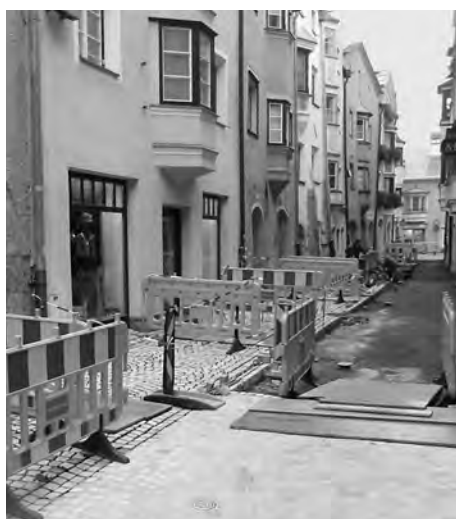
Stein für Stein musste in der Agramgasse neu verlegt werden.
