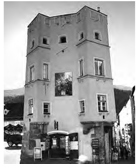
Das Stubenhaus wurde in den 70er-Jahren umfassend renoviert.
