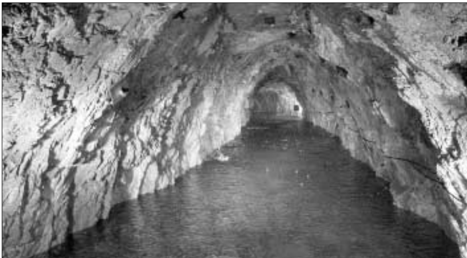
Am Freitag Nachmittag kann man den Trinkwasserstollen im Halltal besichtigen.
