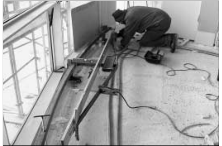
Bei der Montage
