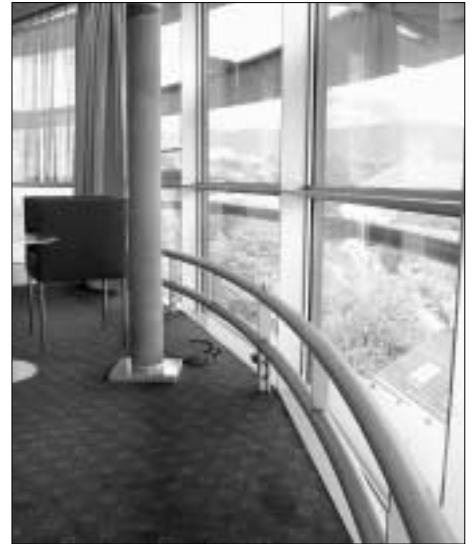
Die Heizkörper in den Parkhotelzimmern verlaufen entlang der Glaswände.
