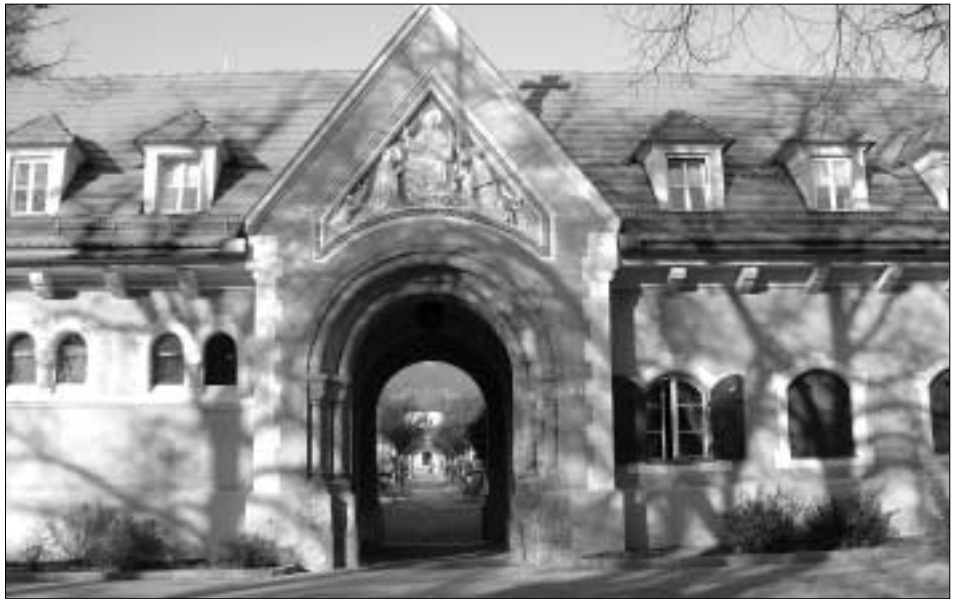
Das Eingangsgebäude des Städtischen Friedhofes wurde saniert.
